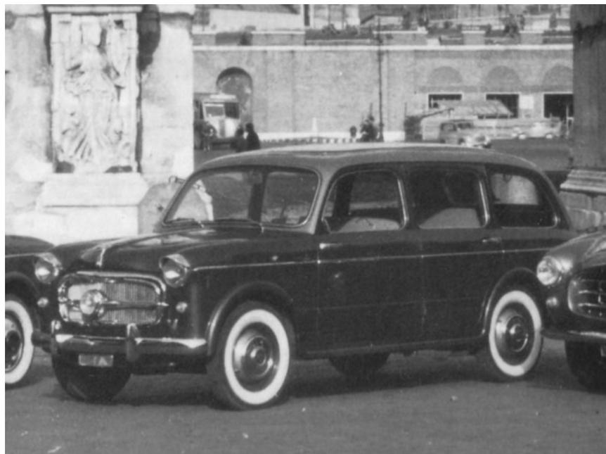
**Fiat 1100/103 Familiare – anno 1955** – motore 4 cilindri in linea 1100 cc – 36 CV – Carrozzeria 2 volumi con 4 porte + portellone posteriore, 5 posti con possibilità di 2 strapuntini per arrivare a 7 posti (per la versione taxi) – lunghezza 3.74 m velocità massima 120 Km/h – consumo 10 Km/l.
